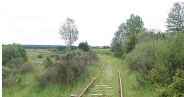
Zerstörerische Einrichtungsarbeiten sind geplant (2009, Foto: Gerhard Reuter)
